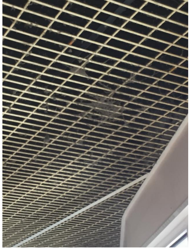
Photo 2 (poussière au plafond)
